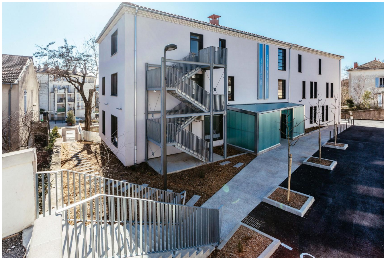
Figure 29 : Rénovation de l'ancienne gendarmerie en centre médico-social | MO : Conseil Départemental des Alpes de Haute Provence | Architecte : R+4 Architectes | Forcalquier (04)
