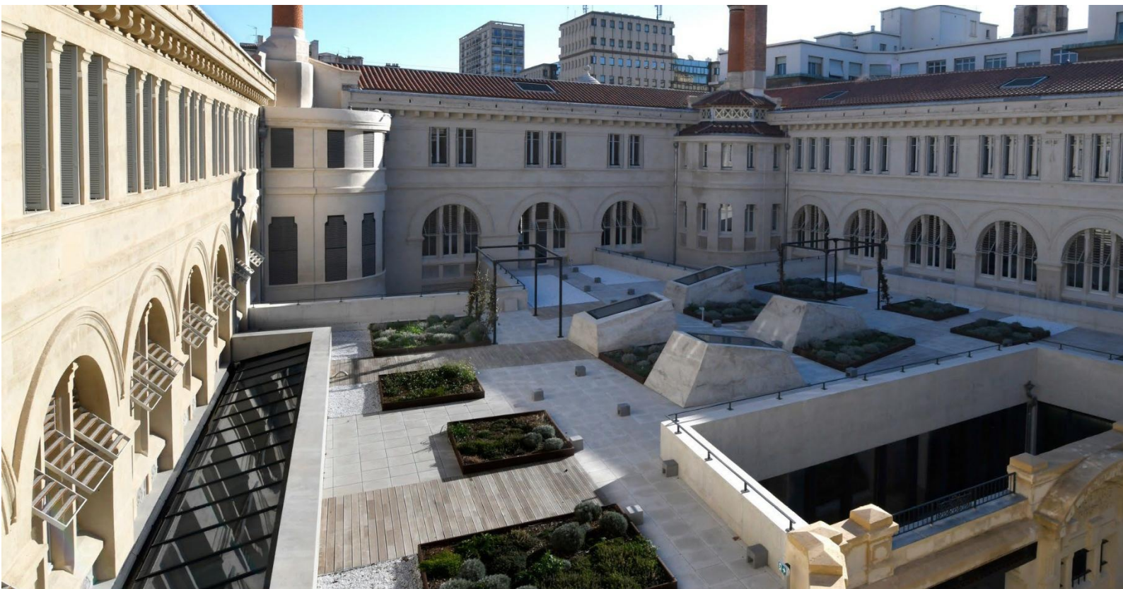
Figure 23 : Restructuration de l'Hôtel des postes Colbert | MO : Poste Immo | Architecte : Architecture & Patrimoine | Marseille (13)
