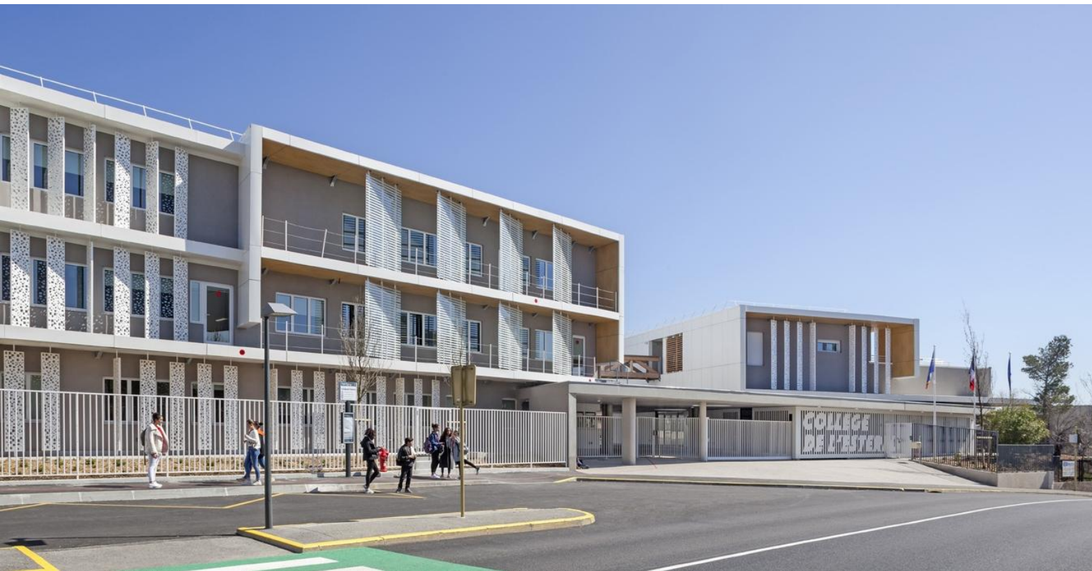
Figure 40 : Collège l'Estérel | WSP France – Eiffage Construction | Saint Raphaël (83)
