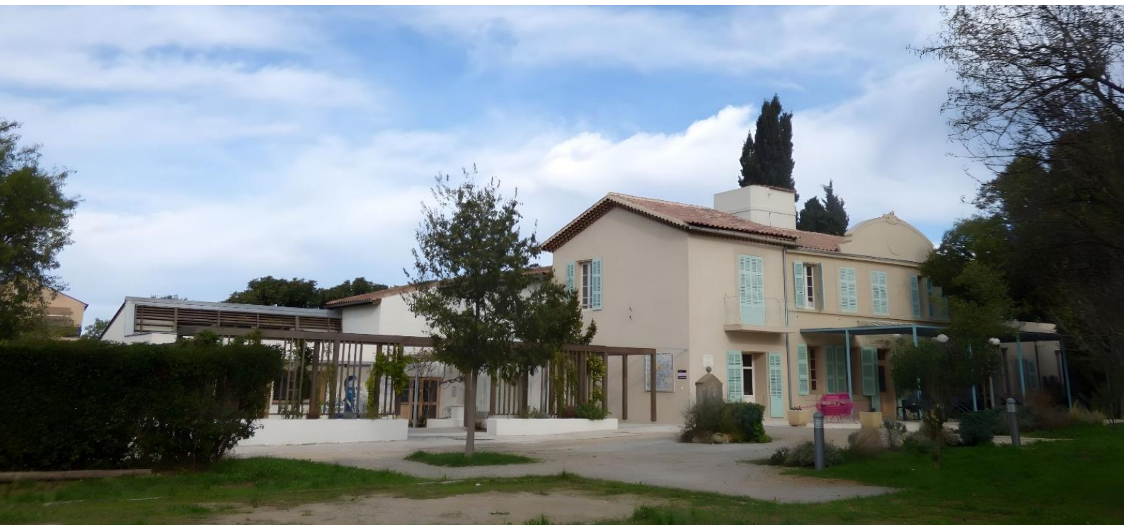
Figure 30 : Rénovation et Extension Le Manier | Architecte : Solari et associés | Marseille (13)
