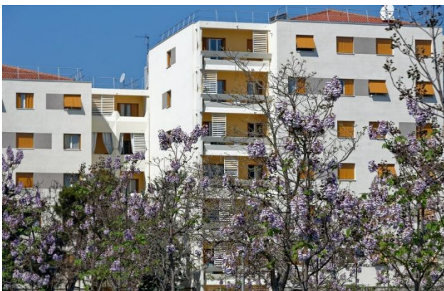
Figure 2 : Résidence Mas Jouffan | Aix en Provence | MO : Logirem | Architecte : Cuadra Architecte
