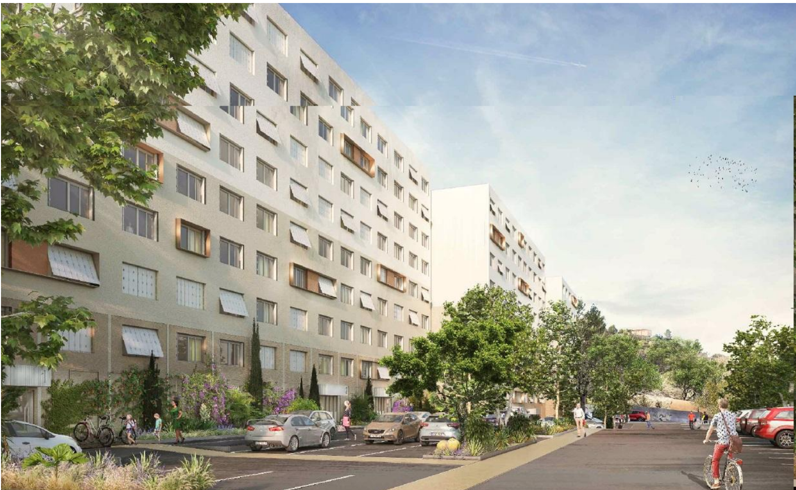
Figure 4 : Résidence Les Jonquilles | Marseille (13) | MO : Vilogia Marseille | Architecte : Avant-Propos Architectes
