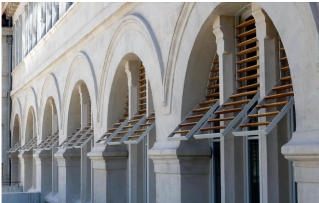
Figure 39 : Protections solaires extérieures | Hôtel des Postes Colbert | Marseille (13) | Architecture & Patrimoine
